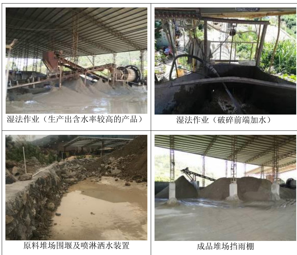
图 4-2 项目废气治理设施图片
